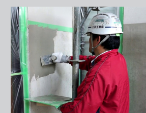
5 経年劣化表面荒れ 剥落箇所モルタル塗りつけ
