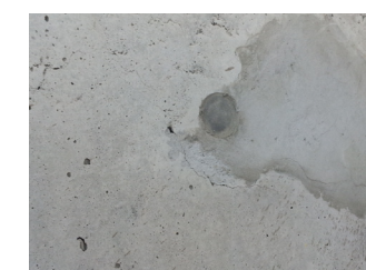
モルタルの補修跡
