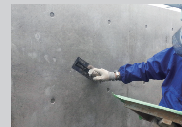
2 不具合箇所の補修材充填
