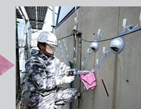
4 ひび割れ 注入
