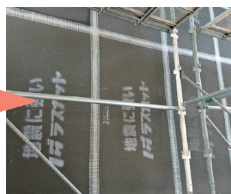
目地処理 (専用コーキング+目地ネット)
