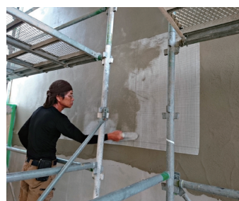
下地2層目+全面ネット伏せ込み 塗り厚:5~8mm
