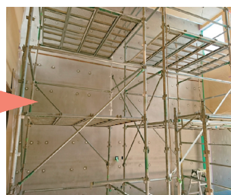
下地2層目完了 Pコンシール
