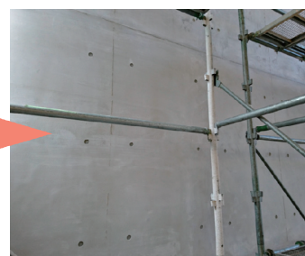
Pコン孔・ベニヤ板目の造形
