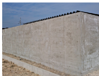
最終下地 3mm厚 Pコン孔・ベニヤ板目の造形
