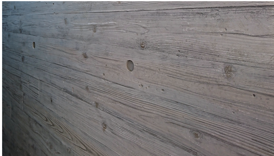
杉板の継目なく、長物で施工が可能。
